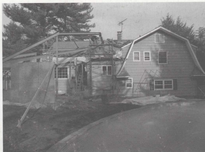
下图：施工现场
