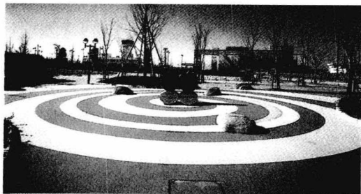
图2-1 现浇混凝土路面
