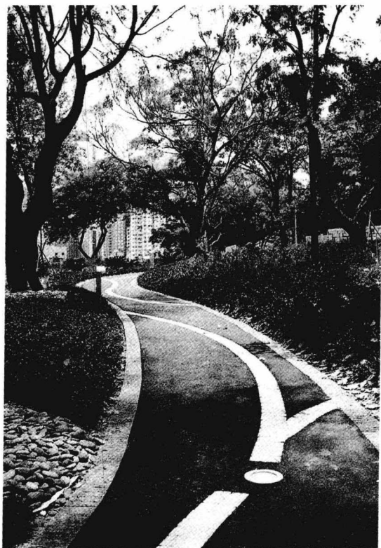
图2-2 沥青混凝土路面
