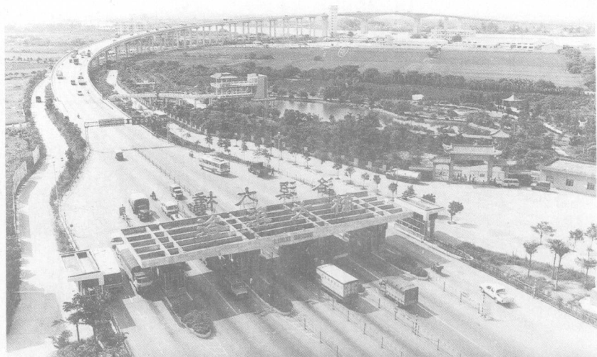
广州洛溪大桥是目前国内主跨度最大的公路桥
