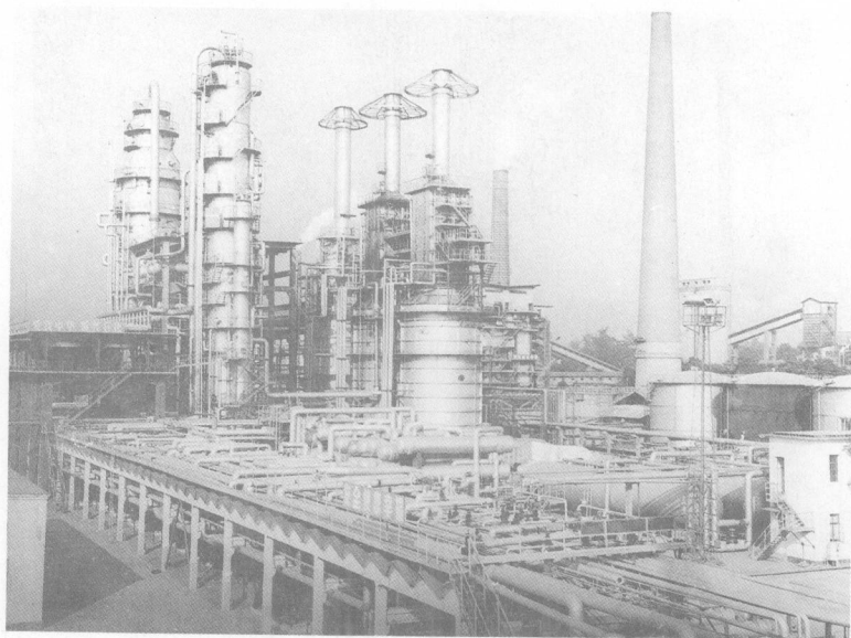
茂名石油工业公司的第二套蒸馏装置
