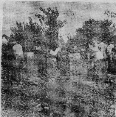
学生正在施工
