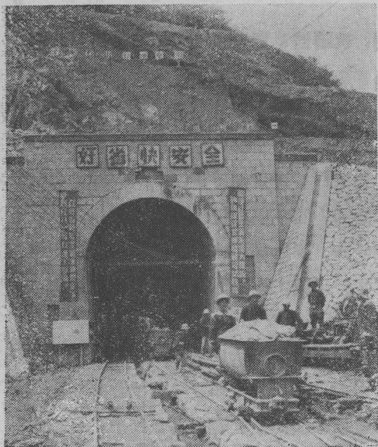
開鑿秦嶺大隧道的工人在運出石碴
