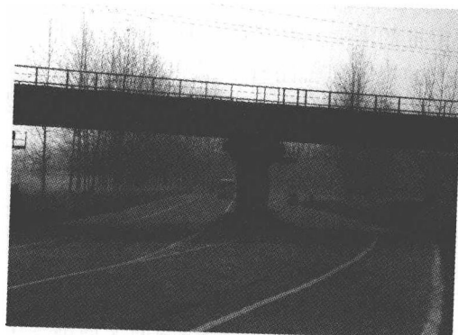
图 1-5 某省道车道上的铁路桥墩
