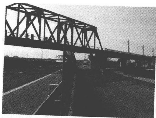
图 1-6 某扩建高速公路行车道上的铁路桥墩
