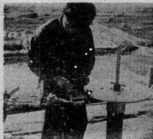
圖2-7 十字板剪切試驗現場操作實況
