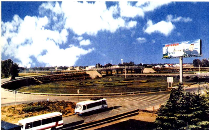
◀ 西铜一级公路三原立交桥
