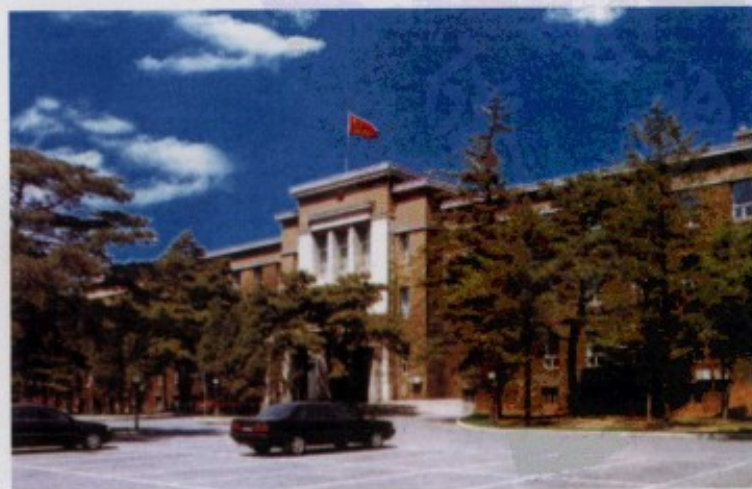
吉林省人民政府办公楼,位于今吉林省长春市人民大街与新发路交汇处东北侧。原址为日本关东军宪兵队司令部。
