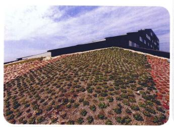
根据绿色屋顶系统和生长媒介深度的不同,直接的雨水流 失可以减少50%到90%。这些水大部分通过蒸发或蒸腾作 用,直接进入自然水循环系统。多余的雨水则随着时间的 积累逐渐流走或排掉。这有助于在降水高峰季节或平时减 轻灌溉系统的负担,如此只用安装较少或更小尺寸的排灌 系统。通过与其他现代雨水处理系统的结合, 如存储箱或 贮留沟渠系统,雨水可以更好地渗透至建筑所在的区域。 在降水处理方面,绿色屋顶在不同的城市都能营造效益, 如降低雨水税等。
