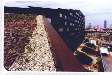
25年。随着时间的积累,屋顶表面/防水层所承受的物理、化学和生物性压力都将造成屋顶的损耗。一般来说,屋顶将承受超过100℃的年均温差和超过日均60℃的温差。紫外线辐射和较高的臭氧层比率都是加速防水层老化的主要因素,最终逐渐导致材料的损坏、收缩、裂缝的形成和渗漏。绿色屋顶能够为防水层提供防护,植被层能够减缓不同季节中温度变化对屋顶的破坏。铺设了植被层的屋顶所承受的年温差不超过35℃,日温差最大也仅有15℃。除此之外,绿色屋顶还将为防水层形成保护,能够避免冰雹、大风、人为破坏和烟花爆竹带来的物理损伤。
