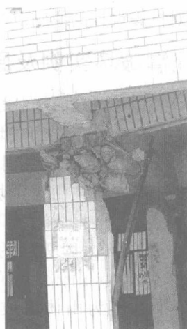
图5 柱上节点破坏
