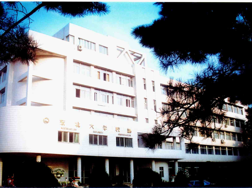
校部 Administration Building
