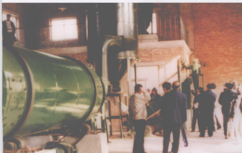
图版10 我国研制的高温、快速93QH-3000烘干机组
