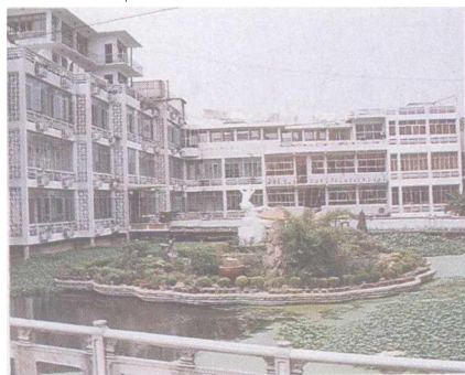
监利县监利饭店水榭楼。
