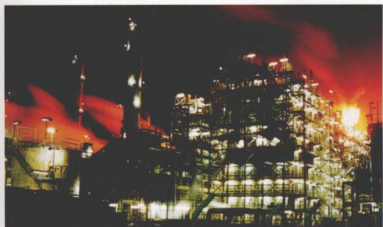
▲ 石化厂局部一瞥。高塔是一个裂解装置,从中可以分离出各种石化产品,并排放出氢气等副产物。
