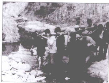
艰苦创业，肩担人抬，搬运固体发动机进山
