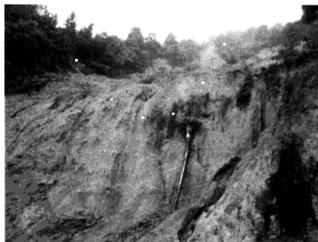
图 1-5 2006 年 7 月，暴雨引发广东省南海西樵山发生泥石流，导致多栋楼房倒塌，12 人伤亡
