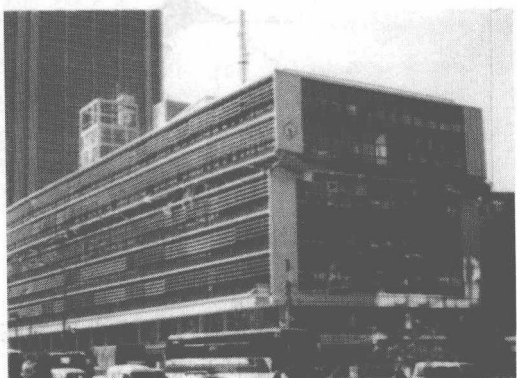
图 1-9 构件强度不足使局部层破坏
