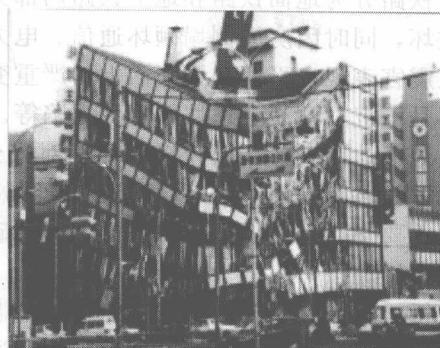
图 1-11 日本地震中房屋整体倒塌
