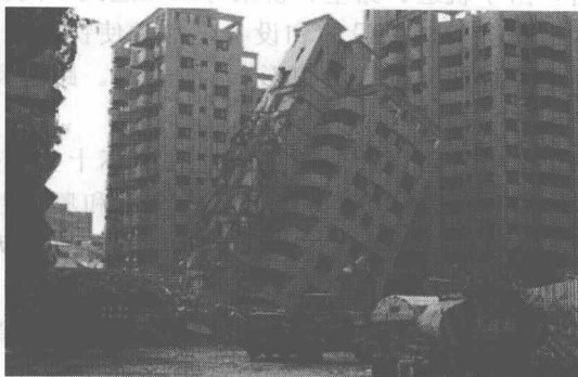
图 1-10 汶川地震中房屋倒塌
