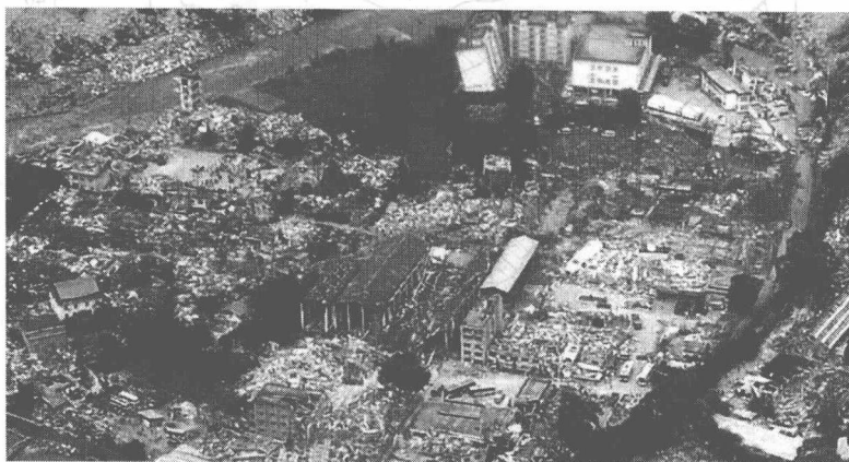
图 1-1 5·12 汶川地震后的北川县城
