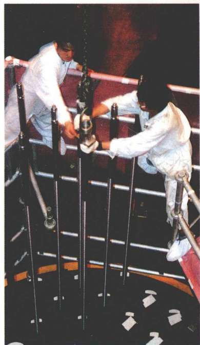
▲ 安装中的控制棒驱动杆
