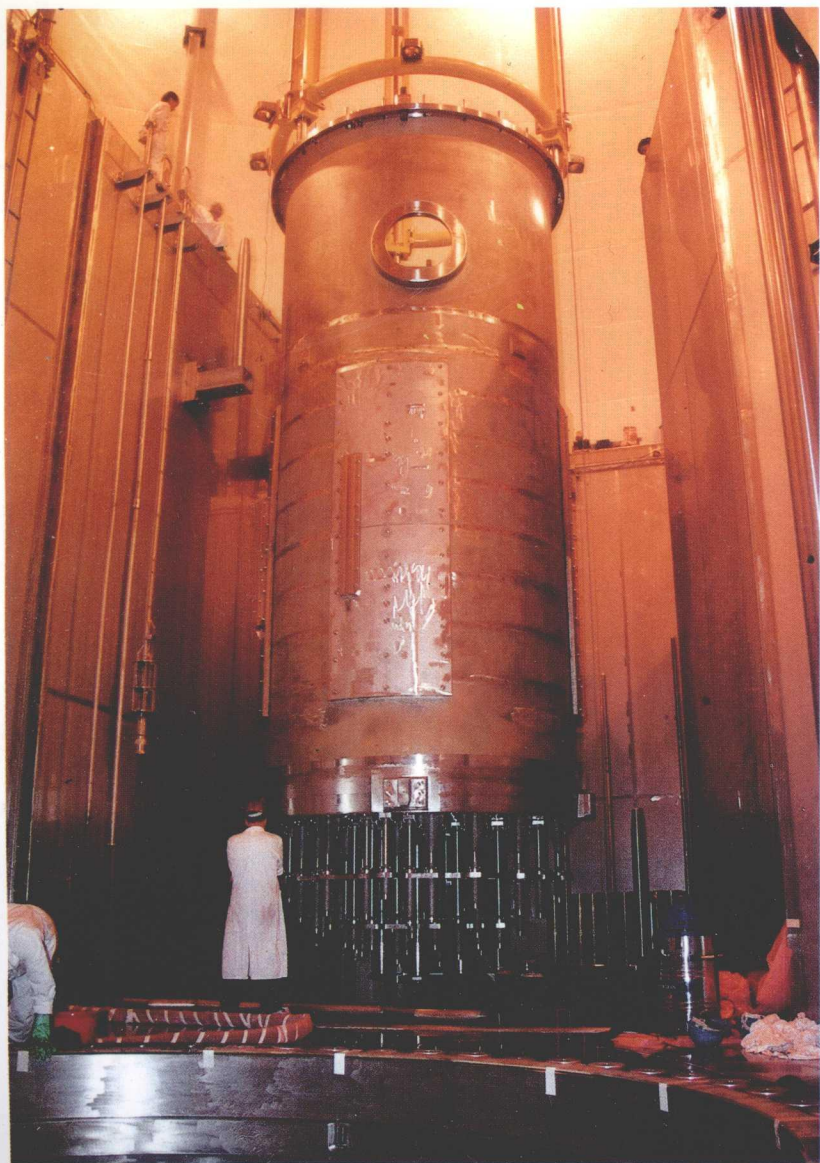
▲ 安装中的控制棒驱动杆
