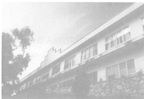
■ 1988年建新课室楼
