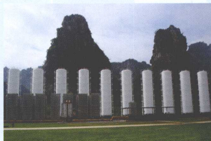
10 \times 100 \text{ m}^3/\text{d} LNG汽化站
