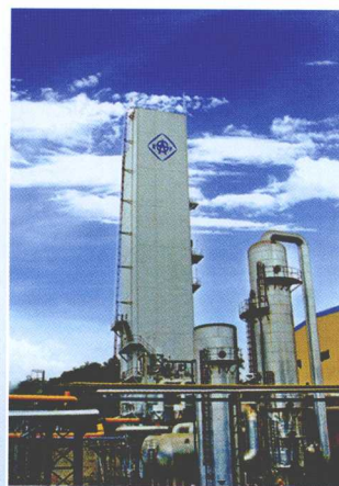
安装在广西柳州钢铁集团有限公司 的28000m 3 /h空分设备
