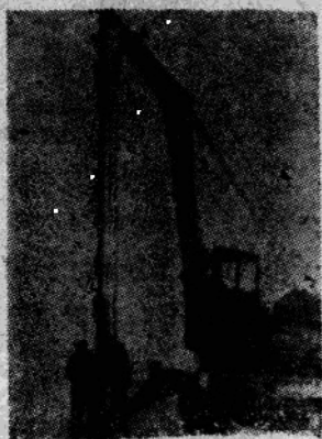
圖 6 用帶有韌性導向杆的振動錘鑽探
