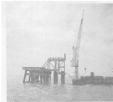
图 2.2-4 钢桩起始平台和钢护筒导向架
