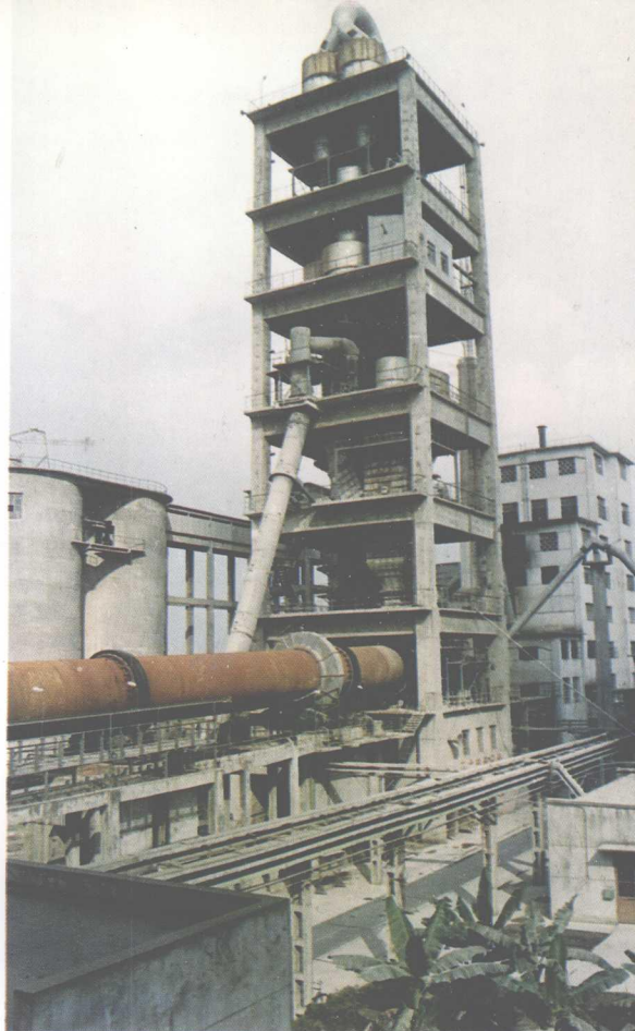
渝江水泥厂窑外分解工艺窑尾系统
