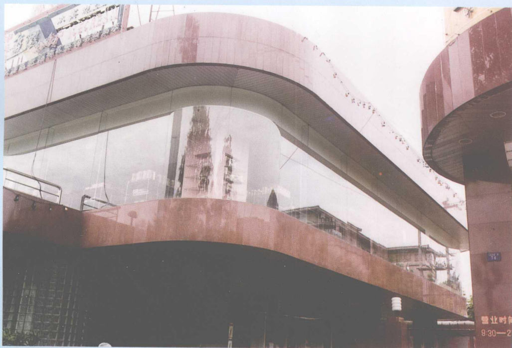
国营一五七厂生产的高级夹层玻璃安装在成都市人民商场
