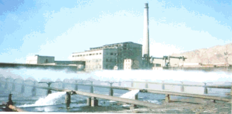
锡铁山矿务局发电厂一角
