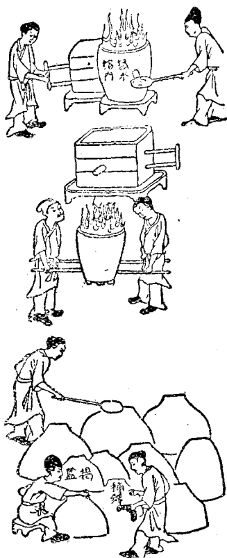
图 4 古代的熔化和澆注工作
