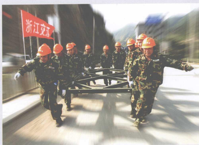
▲ 时间就是生命，早一分架通，救灾物质和设备就能早一天通过。 图为突击队在青川沙洲桥作业场面
