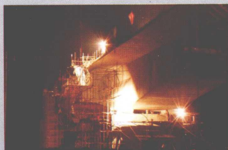
郑西客运专线渭河特大桥(亚洲第一长桥)
