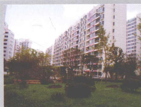
枫林绿洲高层住宅小区工程
