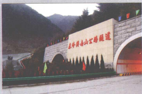
西柞高速秦岭终南山公路隧道工程
