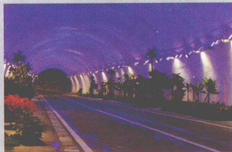
西柞高速秦岭终南山公路隧道工程内景
