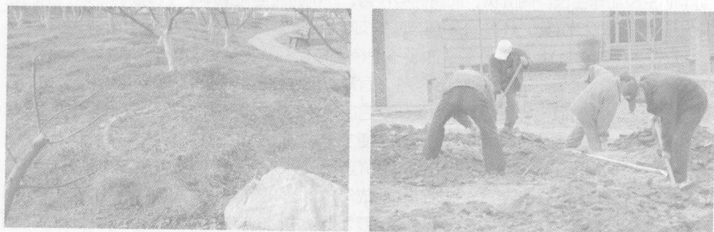
图1-2 白灰线定点，挖坑
