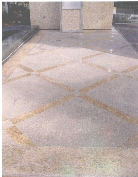
图2-23 地面石材(光面与火烧面)
