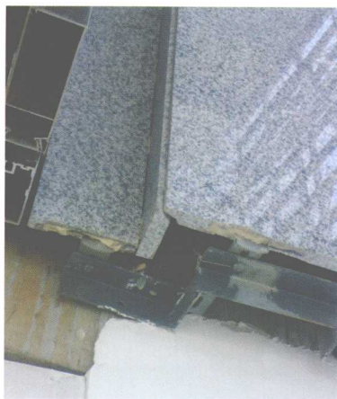
图2-18 干挂施工现场
