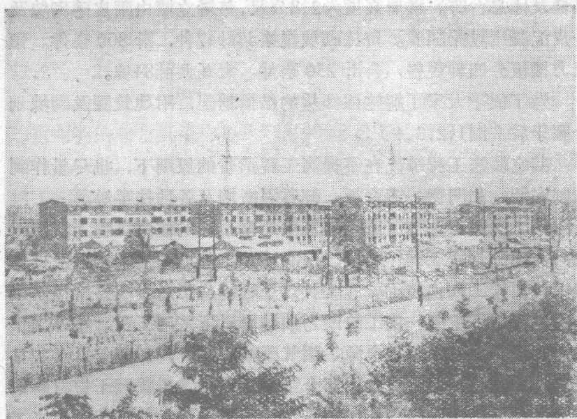
工業化試點工地全貌
