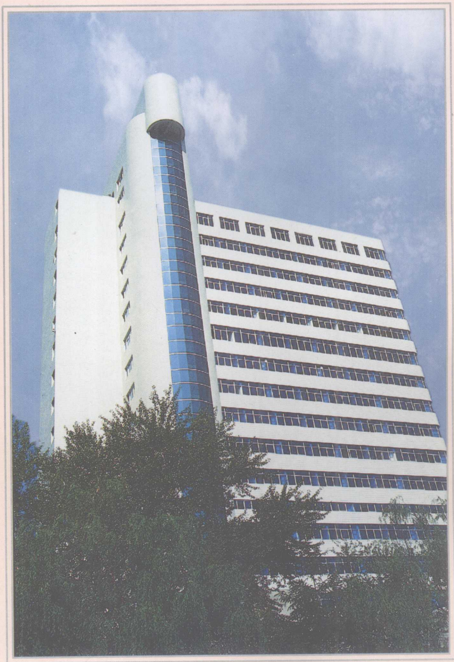
中国人民保险集团 财险总公司青海省分公司 寿险总公司青海省分公司 在建中办公楼
