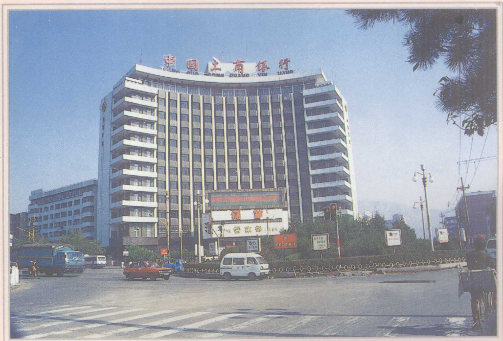
中国工商银行青海省分行办公楼
