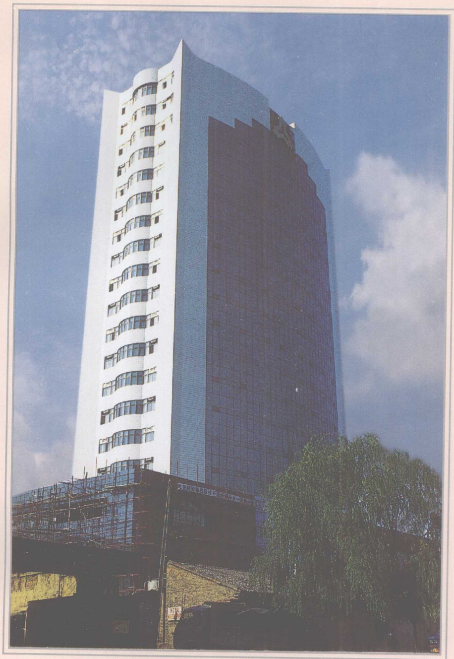
中国人民银行青海省分行在建中办公楼
