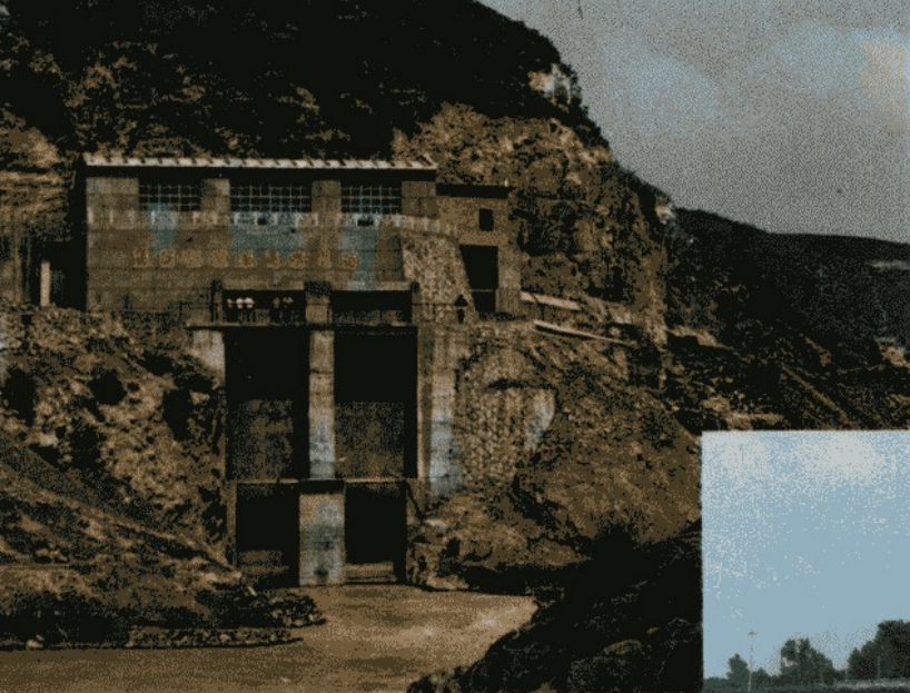
党家湾水电站
