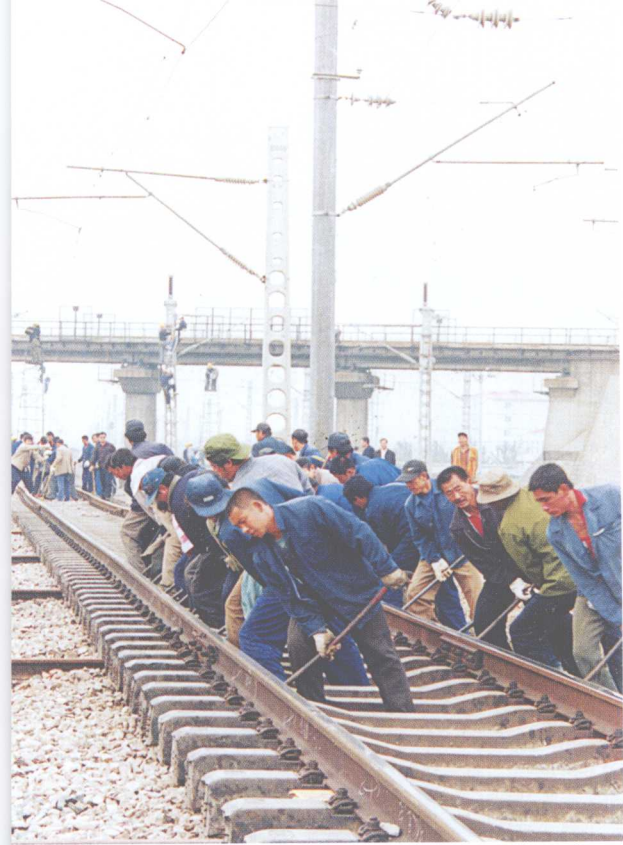
2003 年秦沈线线路拨接施工
