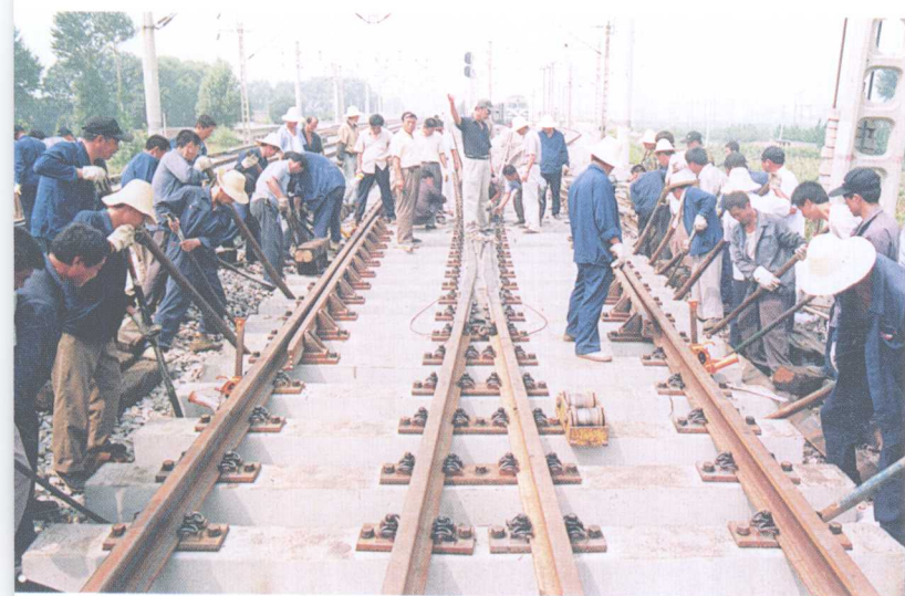
2002年，京秦线抚宁站道岔大修施工现场
