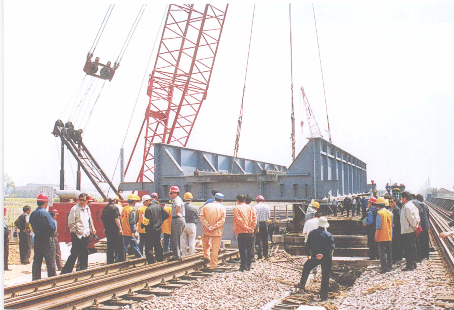
2002 年京山线饮马河大桥钢梁改造施工现场
