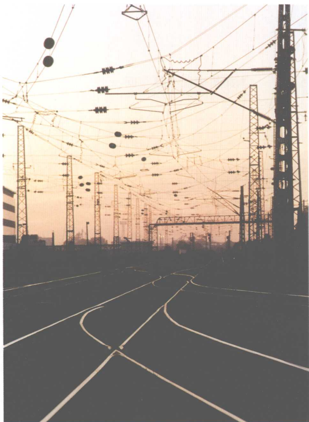
京秦电气化铁道
