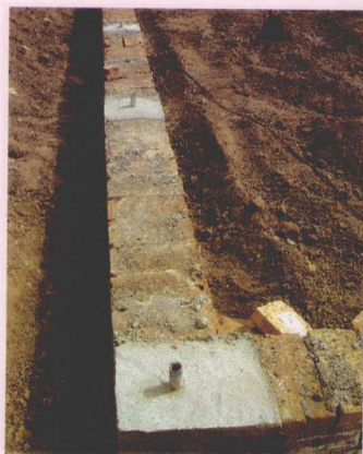
图 1-22 砖混圈梁结构
