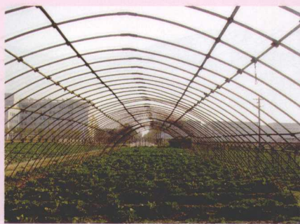
图 1-18 单钢管塑料大棚(9米)
