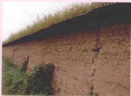
图1-4 墙顶处理(盖石棉瓦)
