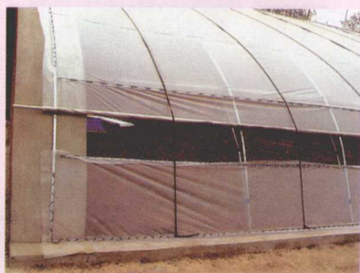
图 1-11 压膜线的固定
