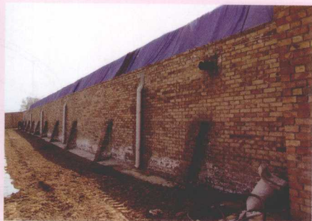
图1-5 墙顶、墙外表处理
