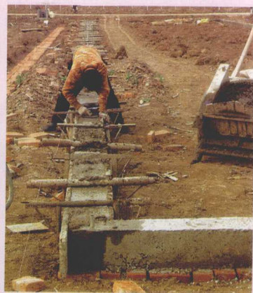
图 1-23 混凝土现浇圈梁
