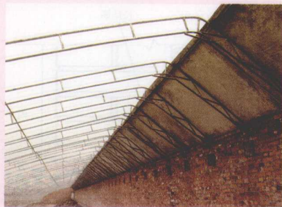
图 1-10 无立柱温室的后屋面
