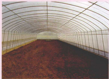
图 1-17 单钢管塑料大棚(8米)
