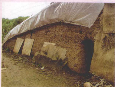
图 1-13 棚膜在山墙端的固定(土墙)
