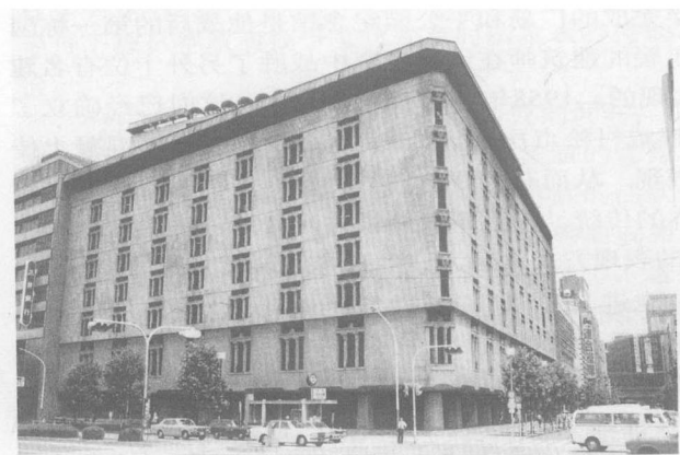
图7 日本生命东京日比谷大厦 (1963年)
