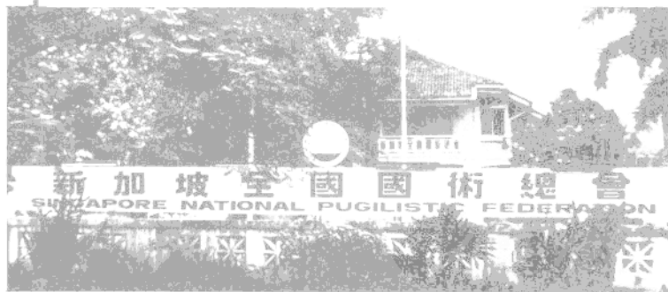
新加坡全国国术总会装修前会所外观。(陈仁金图)
