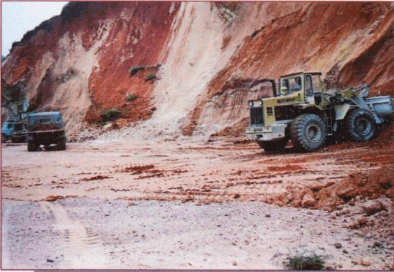
省道改造大埔至三河路段施工現場
