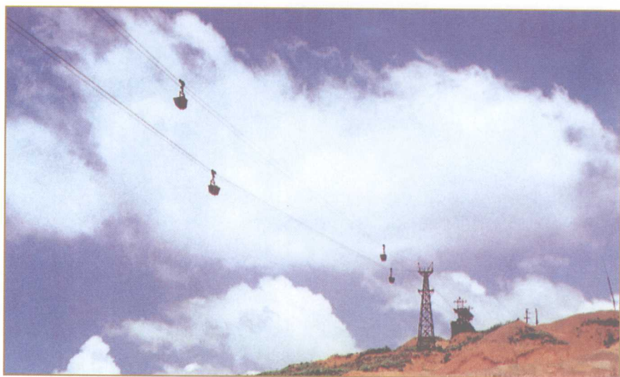
修文铝矿11公里索道运矿线
