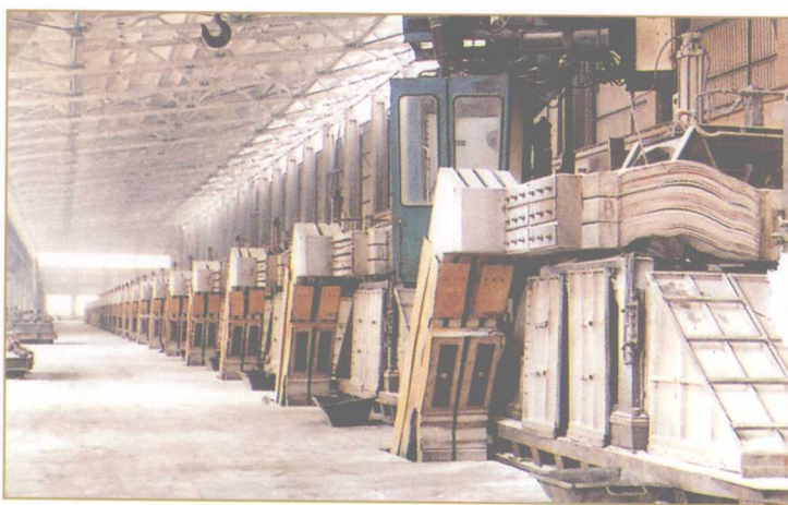
1981年底投产的160KA中间下料预焙 阳极电解槽系列
