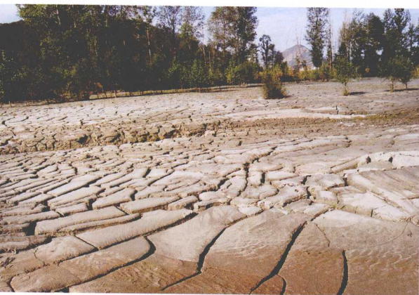
河床上的排渣土发生龟裂
