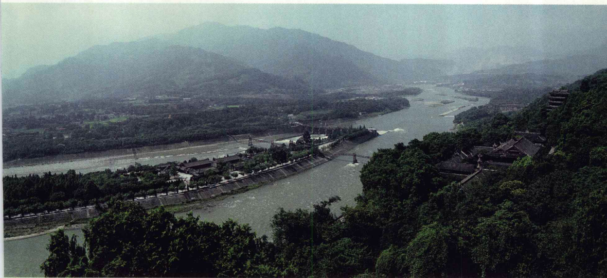
都江堰水利工程。
