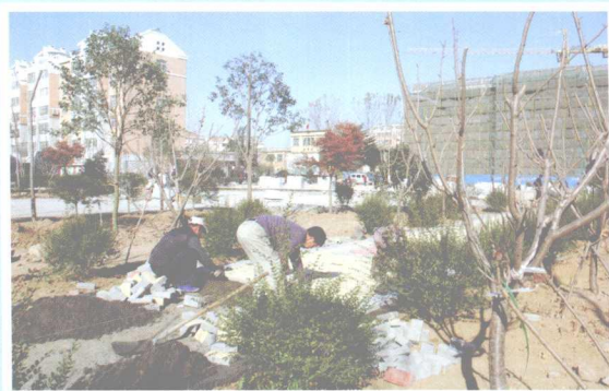
建设中的文化广场
