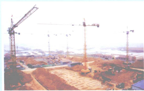
居民新区建设工地
