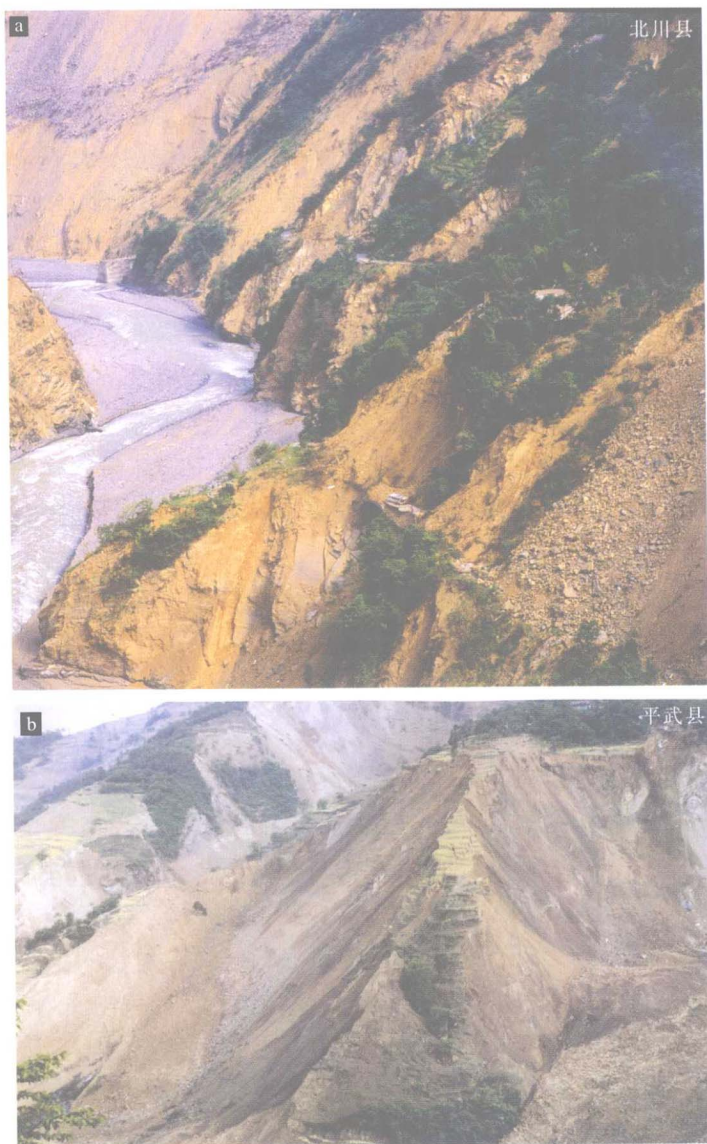
图4 (a)北川县湔江边上的公路被山体滑坡掩埋。(b)地震致使平武县多处发生严重的山体滑坡
