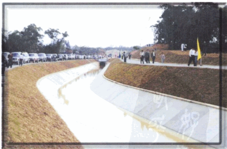
电白县罗热干渠防渗
