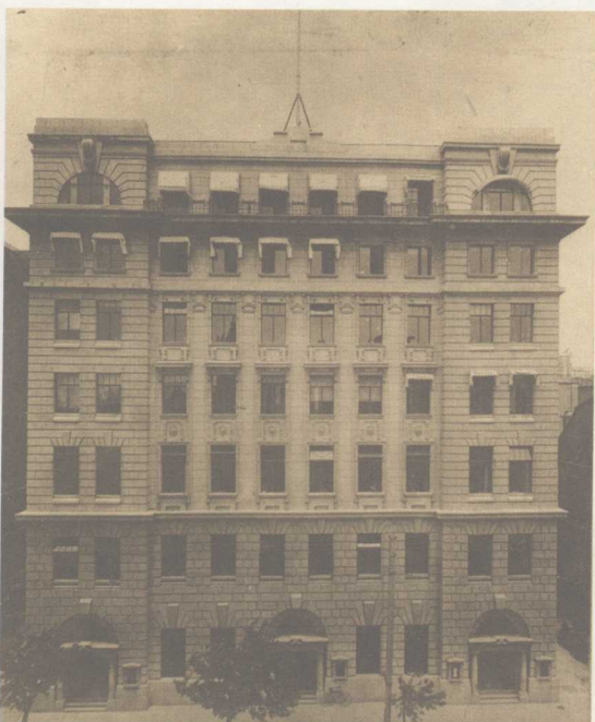
1922 年建成的爱多亚路 4 号（今延安东路 34 号）丹麦大北电报公司大楼，大北、大东、太平洋三家公司于同年迁入该大楼。
