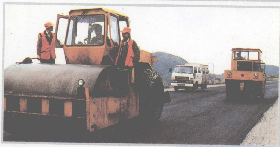
机械化路面压实作业
