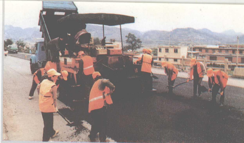
养路工人在进行路面摊铺作业
