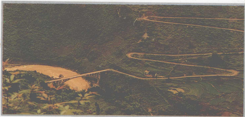
道真县芭蕉湾至桃园线上的 1 孔 90 米双曲拱桥
