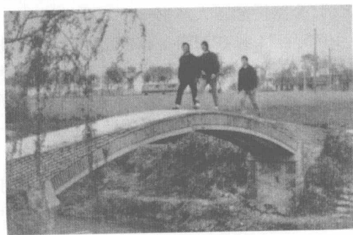
图 1.1.1 我国第一座双曲拱桥——东拱桥
