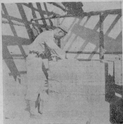
图4 电气分場主任李蘭秀正在砌煉矽鋼的土爐
