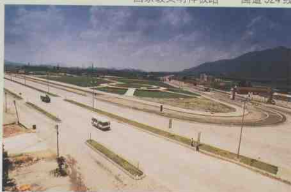
国家级文明样板路——国道324线
