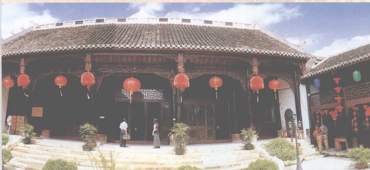
修复后的达德学校旧址
